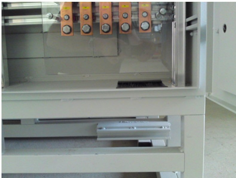
Einführung des Installationskabels.
